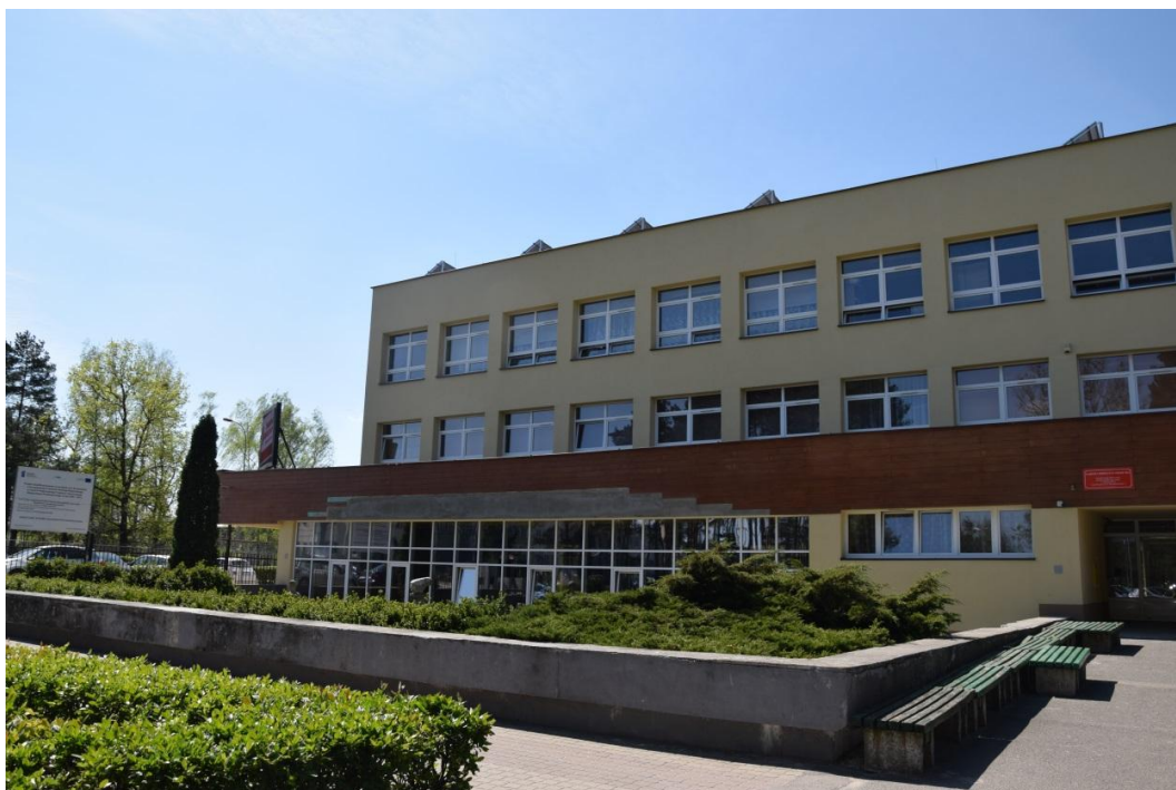
Fotografia 7. Budynek Centrum Edukacji Zawodowej w Stalowej Woli poddany modernizacji energetycznej
