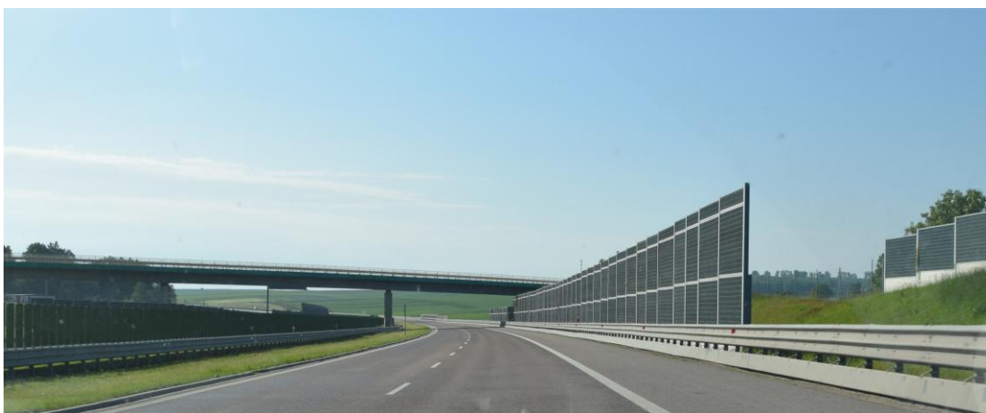
Fotografia 18. Fragment odcinka autostrady A4 Rzeszów – Jarosław
