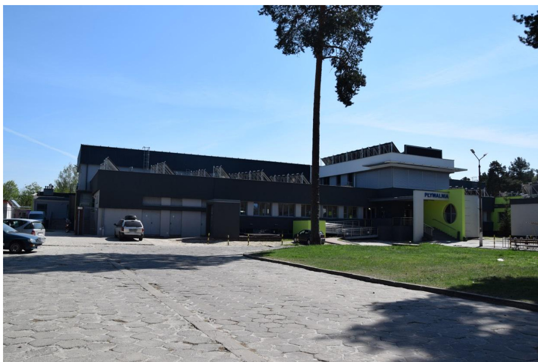
Fotografia 8. Obiekt MOSiR w Stalowej Woli poddany kompleksowej termomodernizacji
