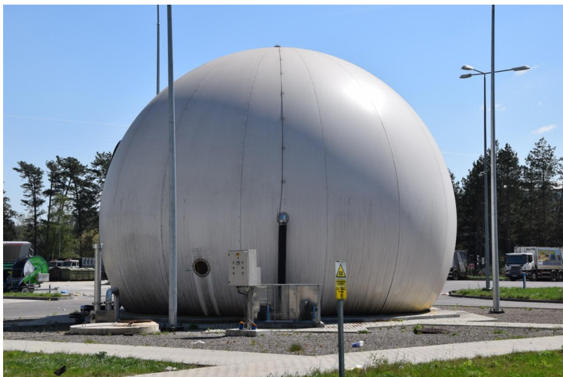
Fotografia 6. Zakład mechaniczno-biologicznego przetwarzania odpadów komunalnych w Stalowej Woli - zbiornik biogazu powstałego w procesie stabilizacji beztlenowej odpadów
