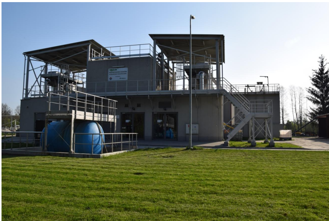
Fotografia 1. Zmodernizowana oczyszczalnia ścieków w Zabajce w gminie Głogów Małopolski
