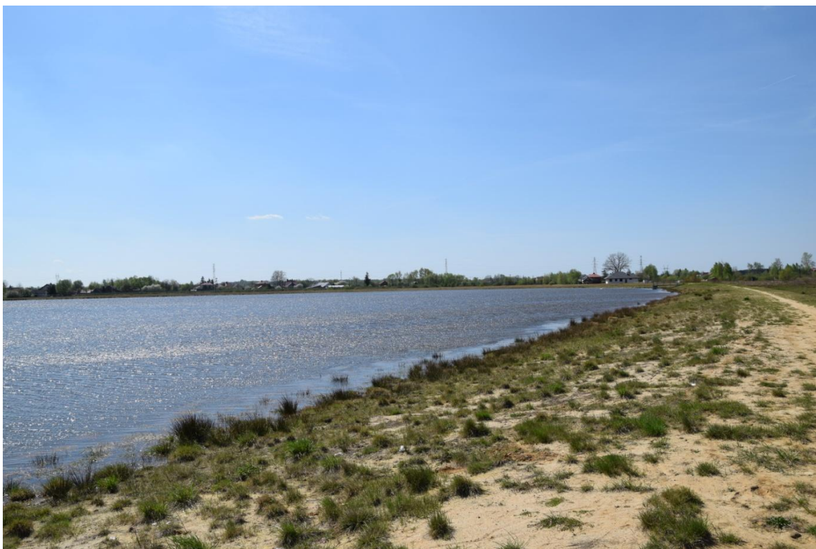
Fotografia 3. Zbiornik retencyjny w Rzeszycy Długiej
